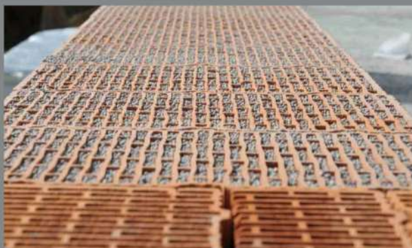
Das Granulat wird in die Hohlkammern des Ziegels eingefüllt!
