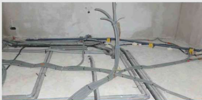
1. Schritt - Rohinstallation Abgeschlossene Installationsarbeiten vor der Wärmedämmung
