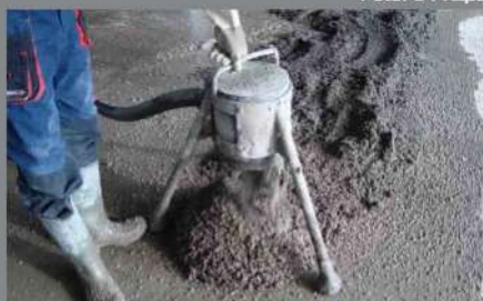
Fördern und Einbringen mit der Estrichpumpe
