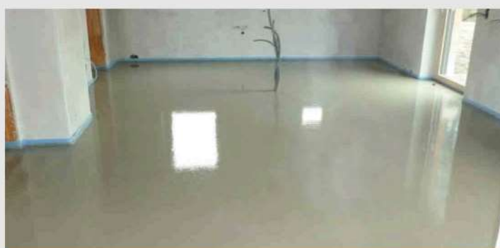
7. Schritt - Estrich wird laut Waagriss, auf das gewünschte Niveau eingebaut
