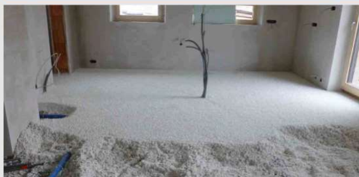
3. Schritt - Dämmschüttung einbauen planieren und auf das vorhergesehene Niveau abziehen
