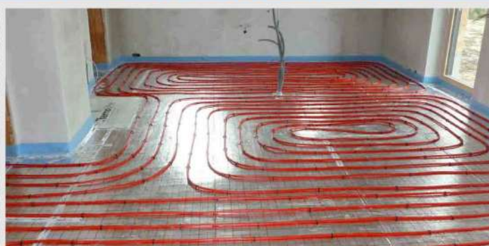
6. Schritt - Verlegung Fussbodenheizung Nach der Austrocknungszeit von mind. 48 Stunden
