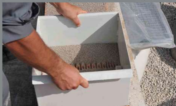
Mittels Granulatschlittens, der über die Ziegeln geschoben wird, erfolgt das Verfüllen mühelos.
