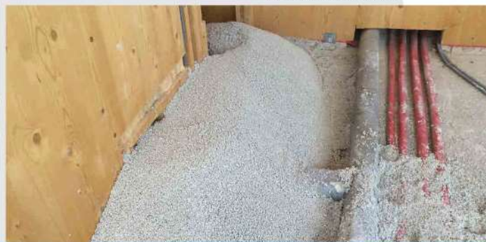
2. Schritt GEOCELL® Blähglas überdeckt alle Installationsleitungen
