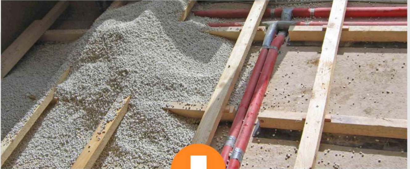
Ausgleichsschüttung zwischen Polsterhölzer
