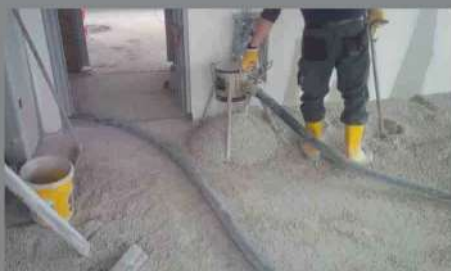
Fördern und Einbringen mit der Estrichpumpe
