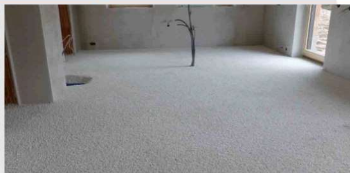
4. Schritt - fertig eingebaut alle Installationsleitungen sind fugenlos umhüllt und somit isoliert
