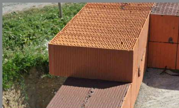
Der Deckenmörtel kann nach Freifegen der Ziegel wie gewohnt aufgetragen werden.
